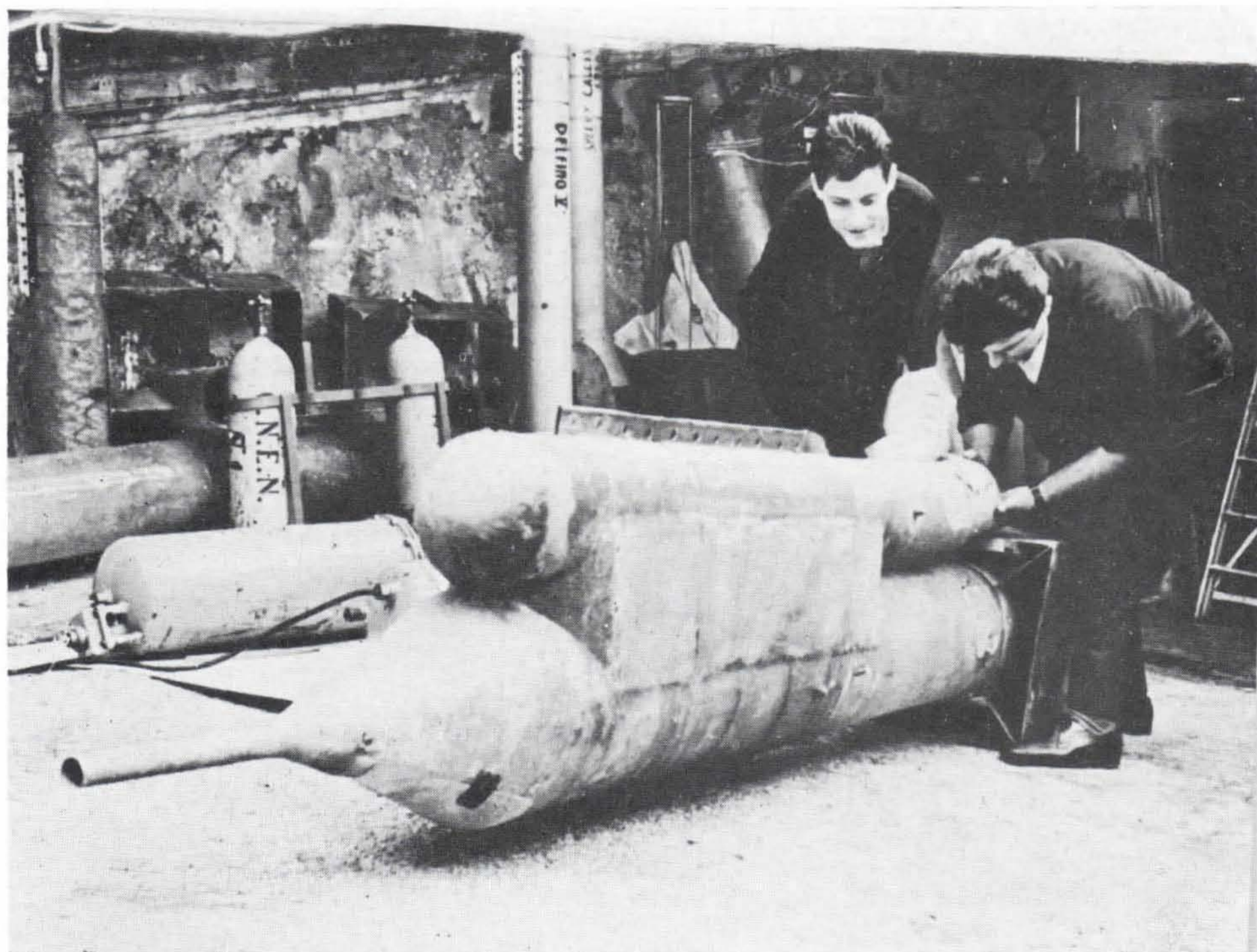
FIG. 7. Una fase di montaggio del sistema automatico subacqueo di analisi dei nitriti e nitrati (da M. BERNHARD, E. TORTI, M. GHIBAUDO, G. ROSSI e A. BRUSCHI, 1967).
